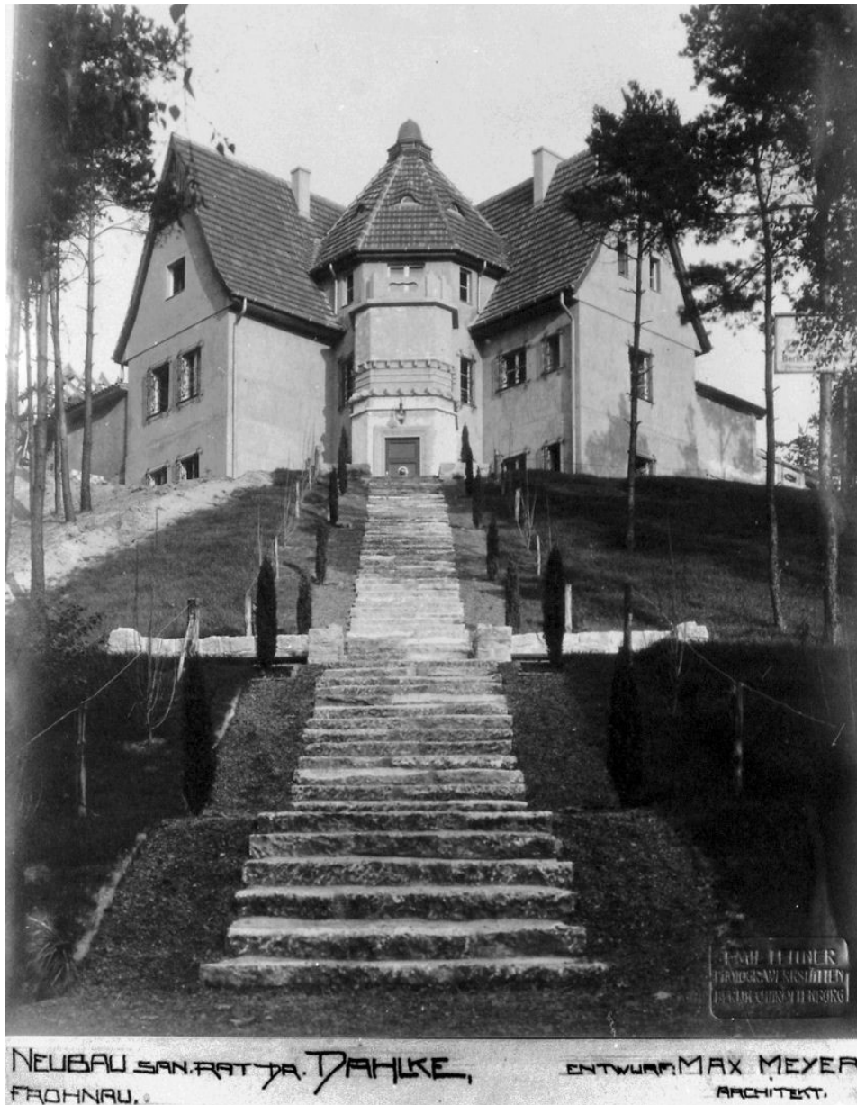
Abb. 1: Treppe zur Praxis des Dr. Dahlke in Frohnau, ca. 1926
