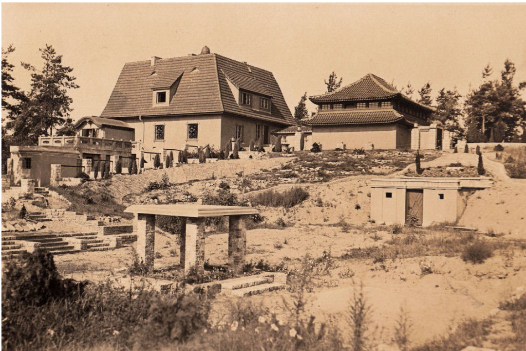
Abb. 7: Frohnau, Haupthaus mit Bibliotheksanhang, Tempel, Vortragsanlage in der Senke mit Hofkeller (rechts im Hang) um 1929
